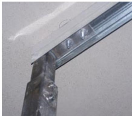
In die Brandwände wurden die Stahlprofile für die Türen befestigt.
