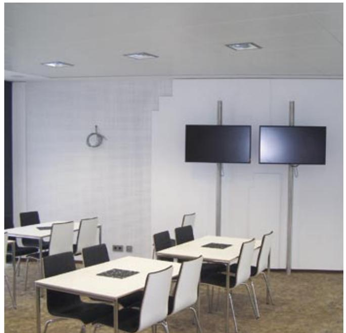
Die neue Cafeteria – die Schallabsorption wurde durch GK-Lochplatten vor den Massivwänden verbessert.
