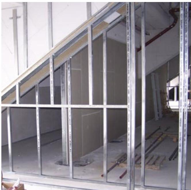
Anschluss einer Installationswand an den Tribünenbalken.
