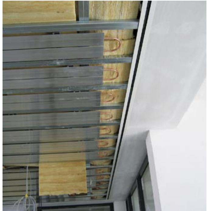
Die DTB lieferte und montierte die innovativen Kühldecken im neuen Besprechungsraum.
