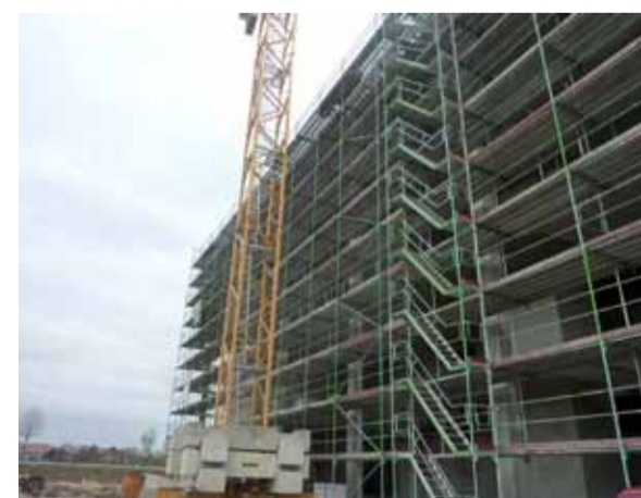
Büro- und Industriegebäude BBF
