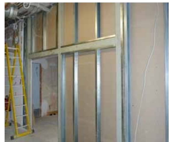
Bevor die Türen eingesetzt wurden, musste eine Unterkonstruktion errichtet werden.
